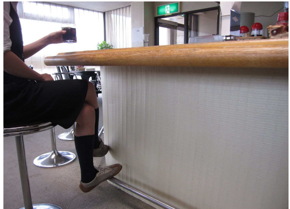
壁紙を貼り付けカウンター壁面に設置
