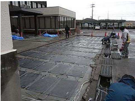
駐車場での敷設作業の様子
